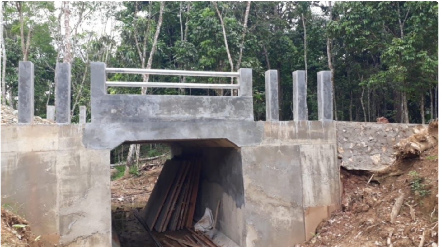
Jembatan Box Culvert Masuk Tahap Finishing
